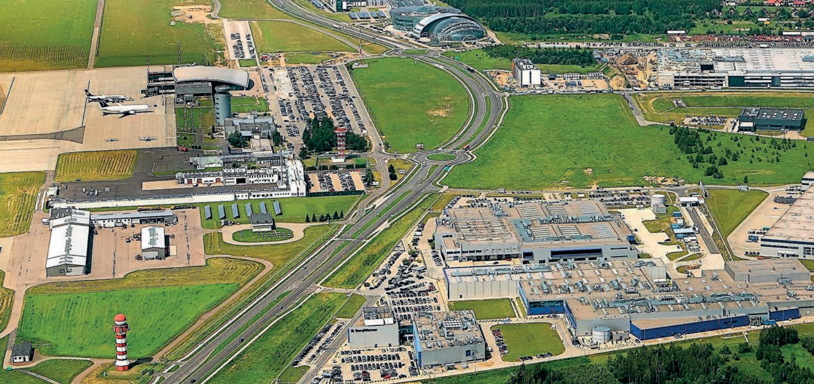
Tereny inwestycyjne w parku Aeropolis położone są przy lotnisku, autostradzie A4 (na zdjęciu) i trasie S19 (w budowie)
