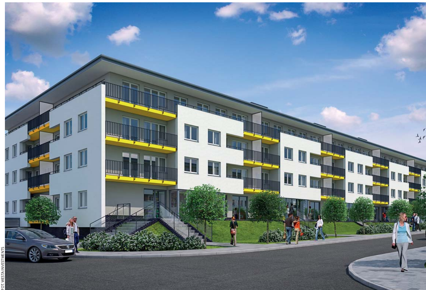
W formule deweloperskiej Westa zrealizowała w Krakowie tak znane przedsięwzięcia, jak Apartamenty Facimiech, Zakątek Tyniecki czy jedną z największych inwestycji mieszkaniowych w mieście – osiedle Harmonia (na zdjęciu), obejmujące 16 budynków i ponad tysiąc mieszkań
