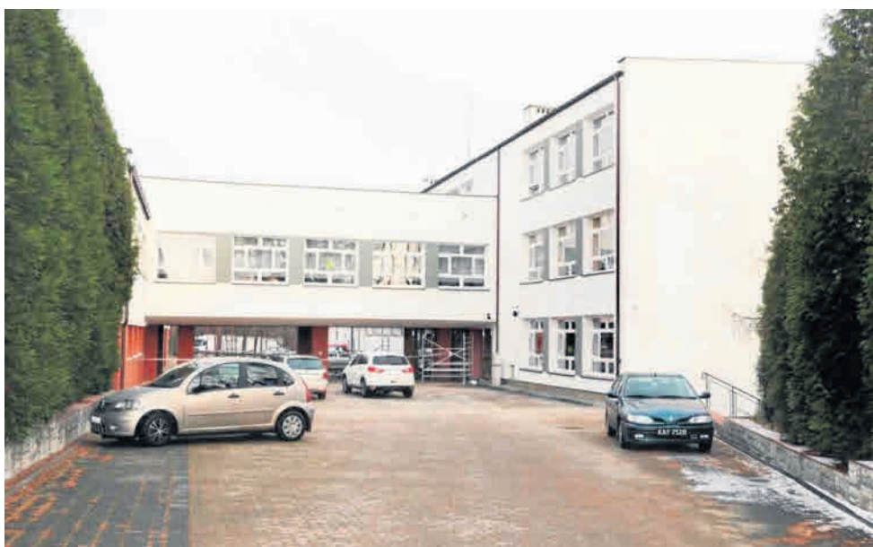
Obecnie w I LO w Olkuszu trwają prace remontowe. Budynek szkoły zostanie odnowiony.
