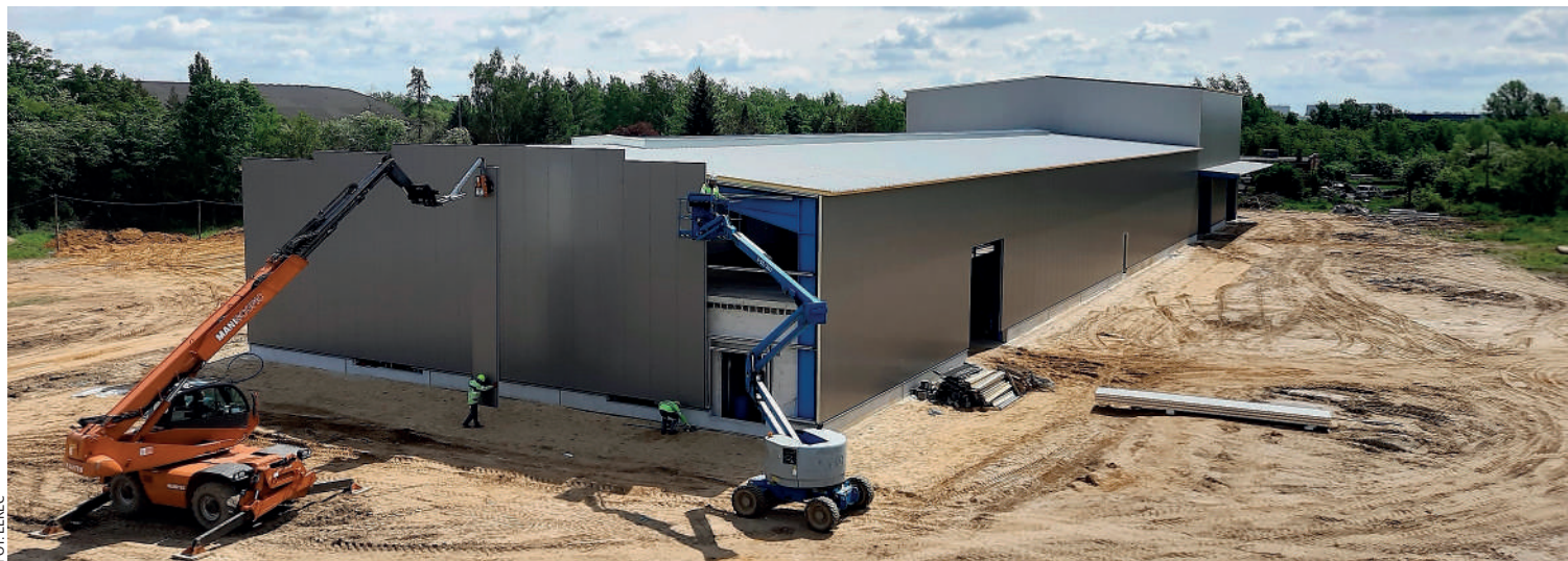
...a tak budowana nowa hala w Skarbimierzu. Jej otwarcie planowane jest na koniec września.
